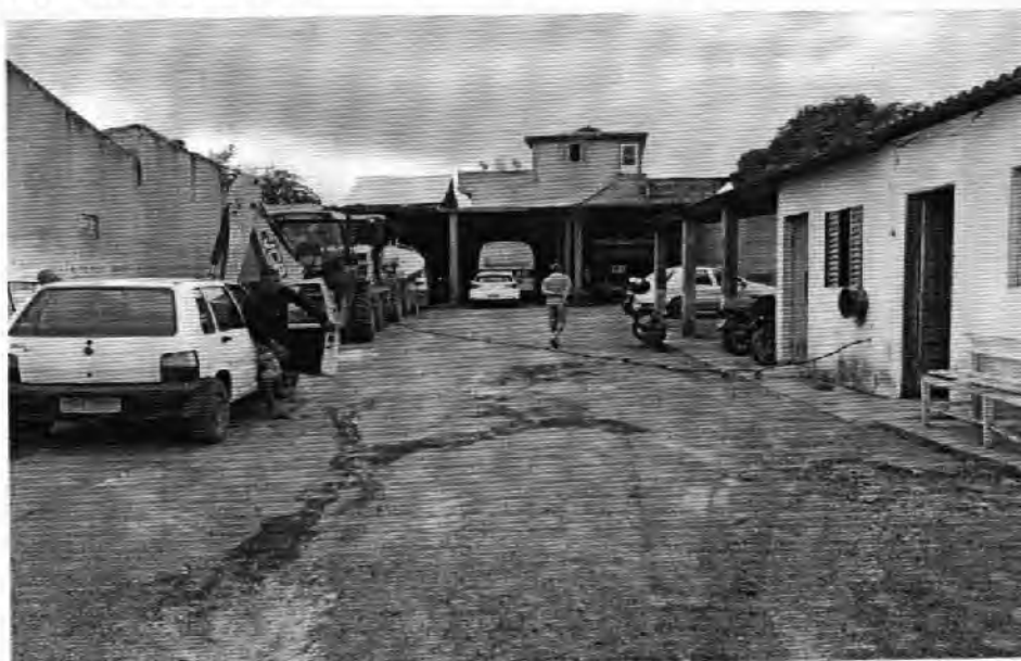
FOTO 2: Entrada principal (Garagem e oficina)
