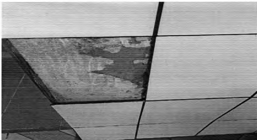
FOTO 5: Na cozinha observou-se deslocamento das placas cerâmicas.
