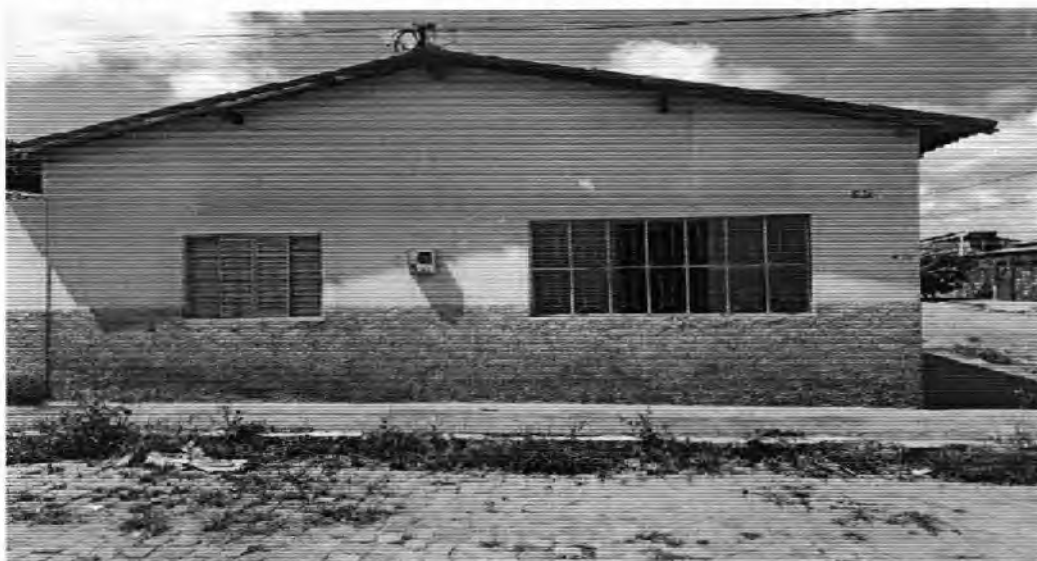
FOTO 1: Fachada principal da Guarda Municipal.
