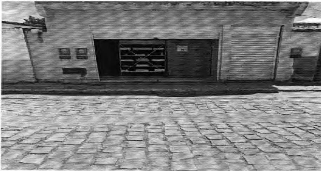
FOTO 1: Fachada principal da Sede dos Conselhos da Educação.
