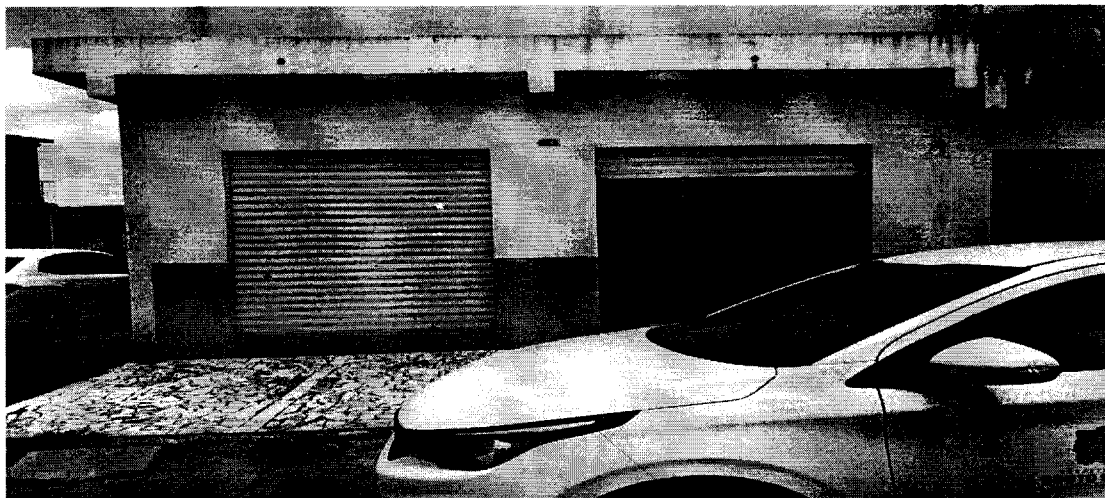
FOTO 1: Fachada principal Almojarifado da Secretaria de Educação.
