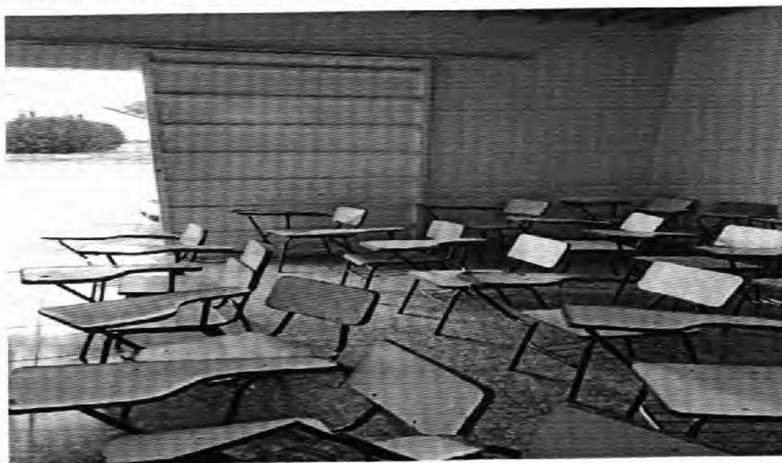
FOTO 2: Sala de aula 1.
