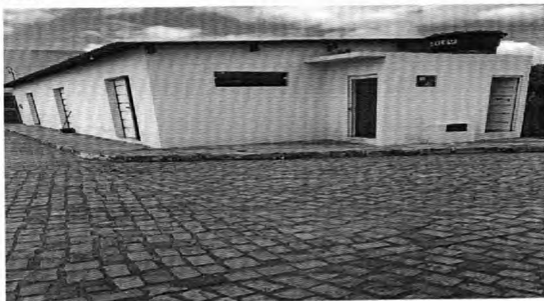
FOTO 1: Fachada principal do Anexo do Colégio Estadual.
