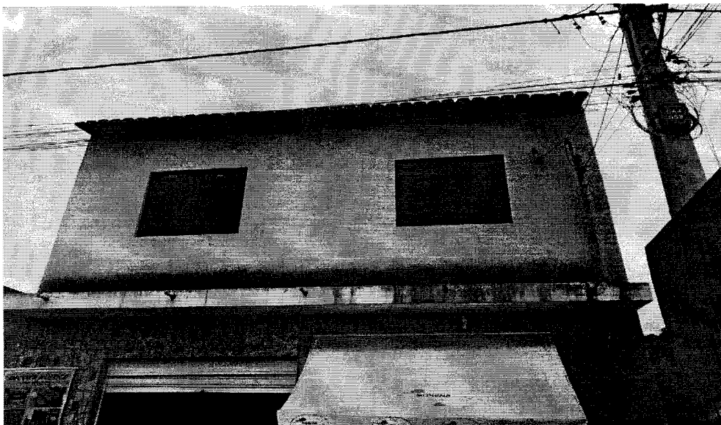
FOTO 1: Fachada principal da secretaria municipal de comunicação.
