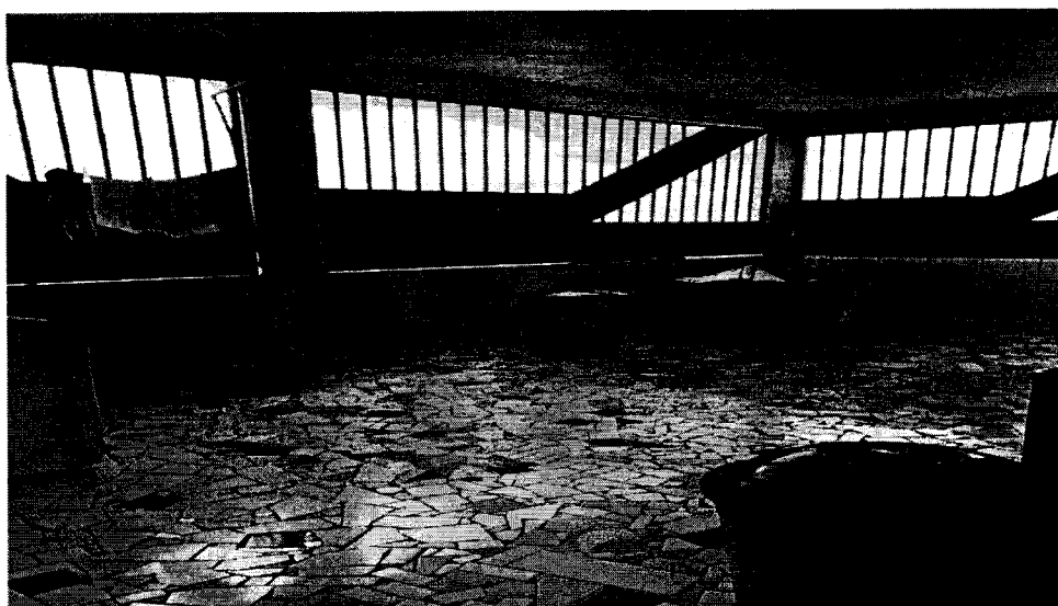
FOTO 10: Area de serviço.
