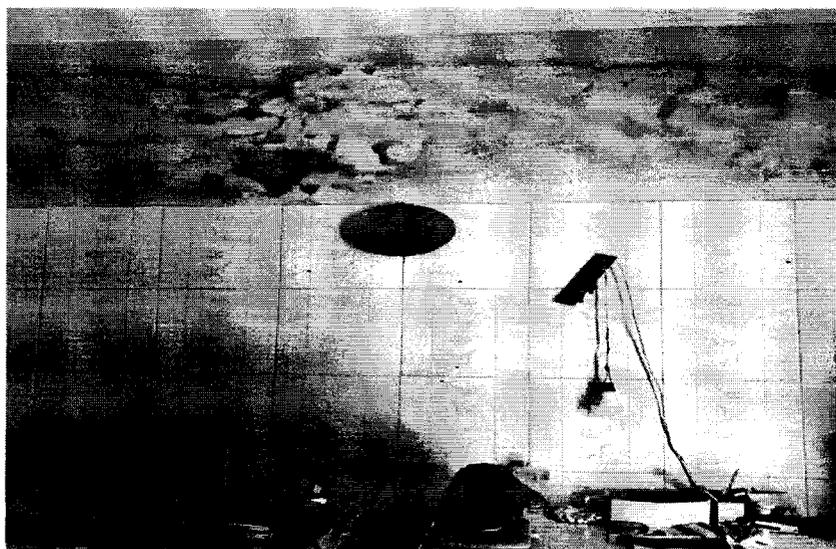
FOTO 5: Sala de trabalho 2, obs.: infiltração na parede.
