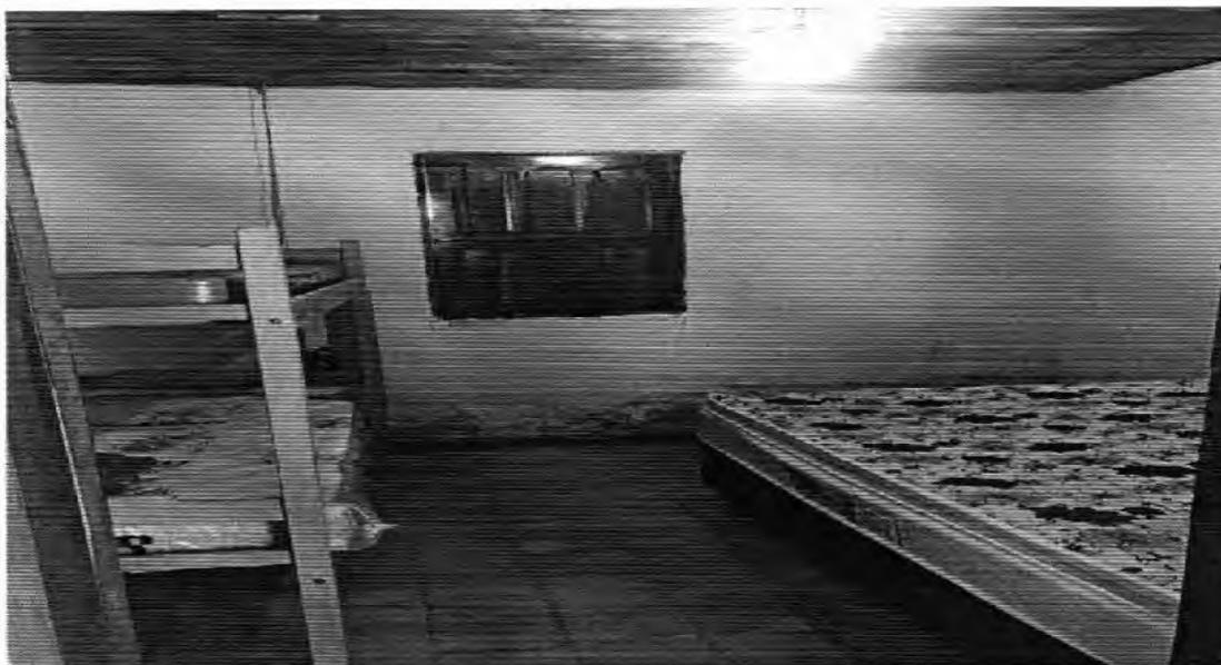
**FOTO 7: Quarto 2 Obs.: infiltração nas paredes em decorrência da umidade do solo.**
