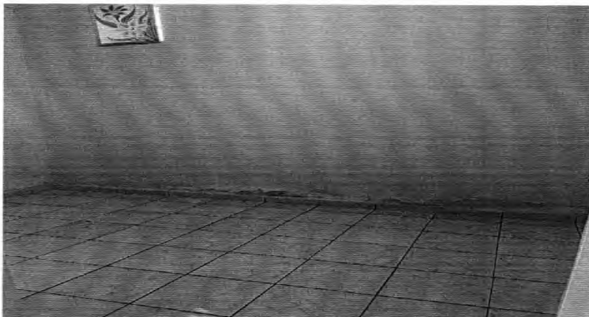
FOTO 6: sala de trabalho 2
