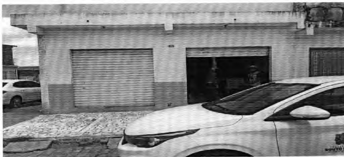
FOTO 1: Fachada principal Almoarifado da Secretaria de Educação.
