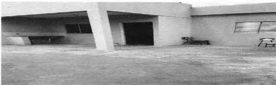
FOTO 8: Área de Serviço.
